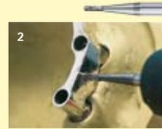
2 Avec le foret de centrage, on détermine la position du verrou et l'on aménage une petite cavité.
