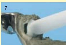
7 Obturer les deux ouvertures au niveau du châssis avec de la colle DTK. Après durcissement de la colle, terminer le châssis.
