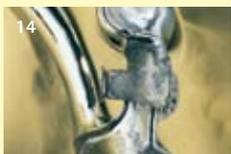
Le verrou à douille est fixé avec de la résine sur le châssis squeletté.
